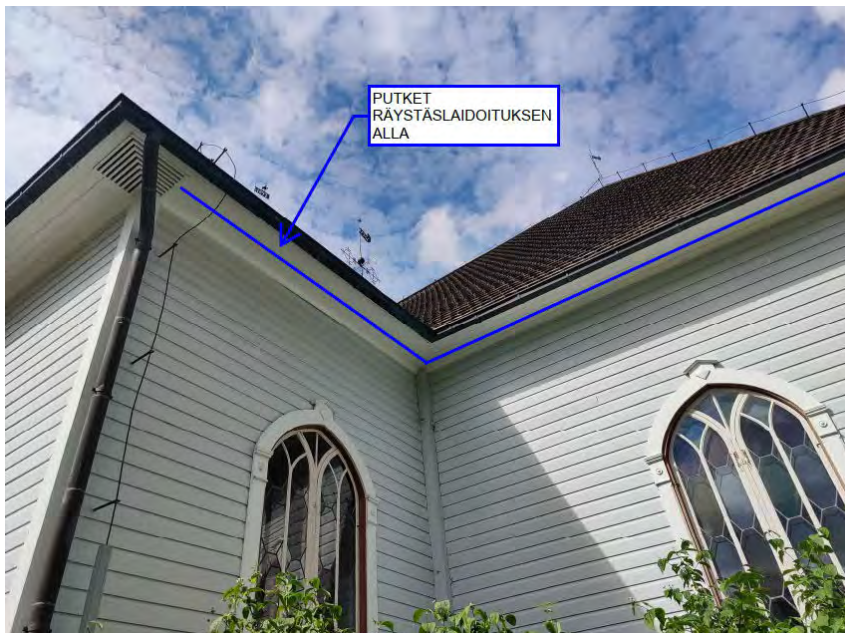
Kuva 2. Ulkopuolisten sprinkleriputkien sijoitus.
