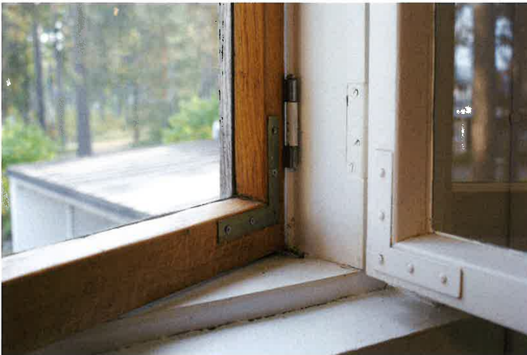
Samat rakenteet ja detaljit toistuvat kaikissa ikkunoissa. Tässä F104.4. Ikkunat F104 ovat sopivan kokoisia tuuletukseen, ja niissä onkin kiintopainike.
